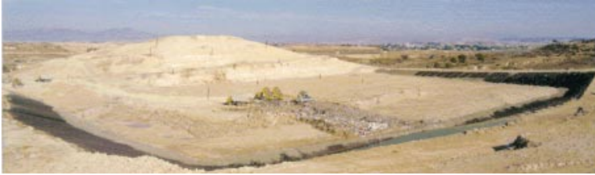
Vertedero controlado. Extracción de biogás
